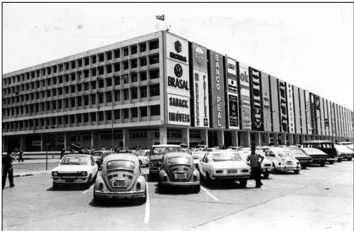
Figura 1 - Fachada do edifício em suas primeiras composições. Foto: Autor desconhecido.
