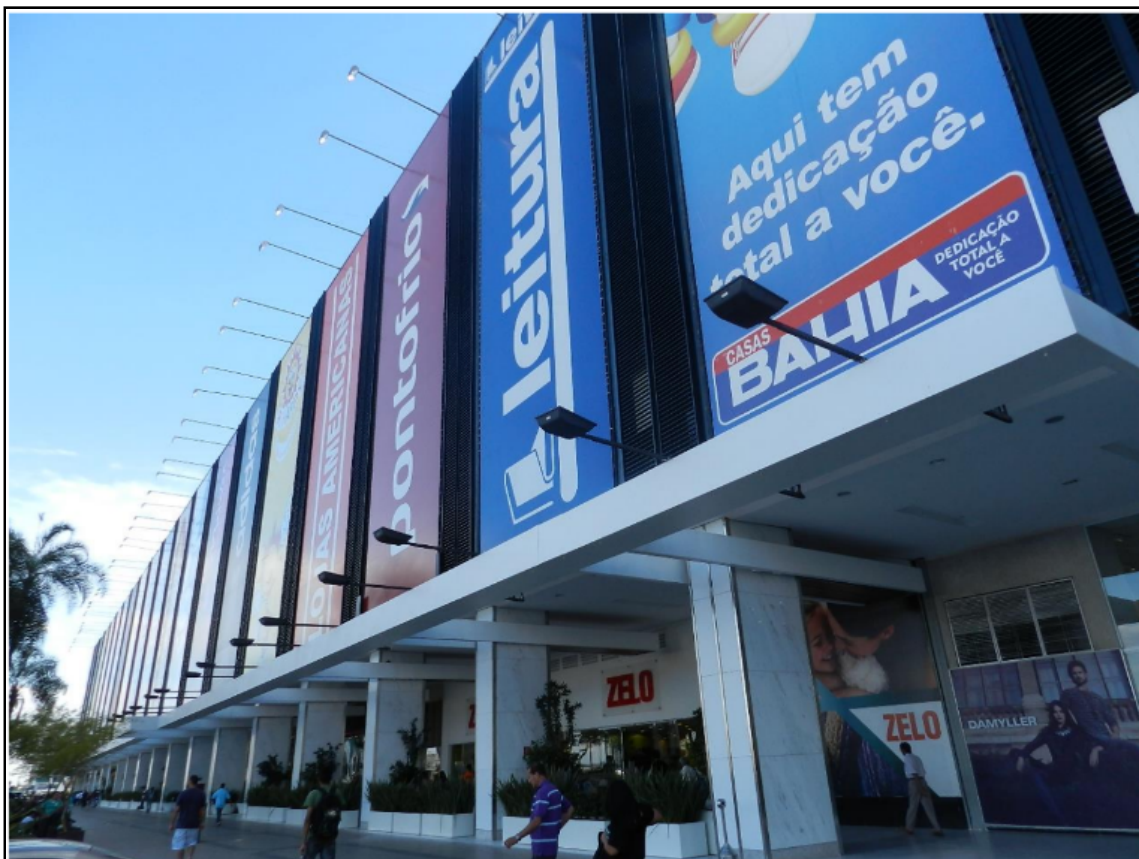
Figura 3 - Fachada do CNB nos dias atuais. Foto: Laudo Técnico CNB.
