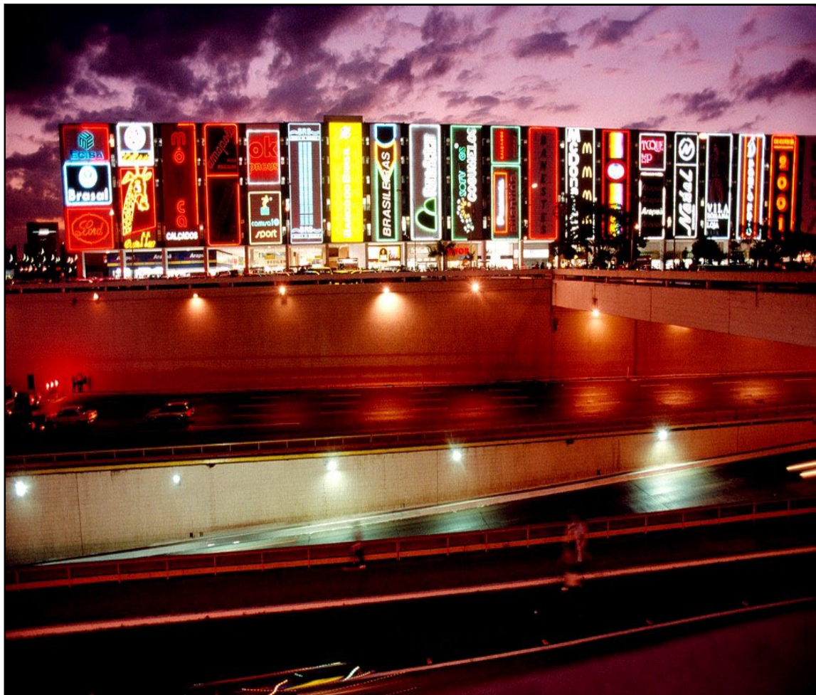
Figura 2 - Disposição dos painéis da fachada do CNB nos anos 80. Foto: Patrick Grosner
